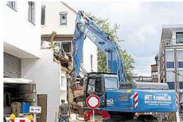
Alt macht Platz für Neu: Am Sedanplatz an der Ecke Halenbeckstraße wird abgerissen für einen Neubau. Hier soll ein vierstöckiges Geschäftshaus mit Staffelgeschoss entstehen. GKE-FOTO: CHRISTIAN KOSAK
