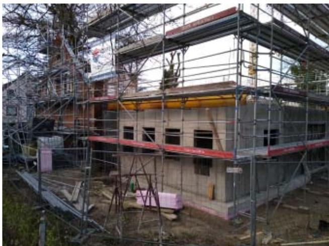
*Auf dieser Aufnahme ist der Übergang von der erhaltenen Fassade zum Neubau zu erkennen. Der Zwischenraum wird als gläsernes „Scharnier“ gestaltet. (03.04.2022)*
