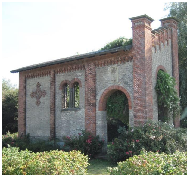
Schöpfwerk Wasserhorst, altes Kesselhaus (Foto: H. Schröder)
