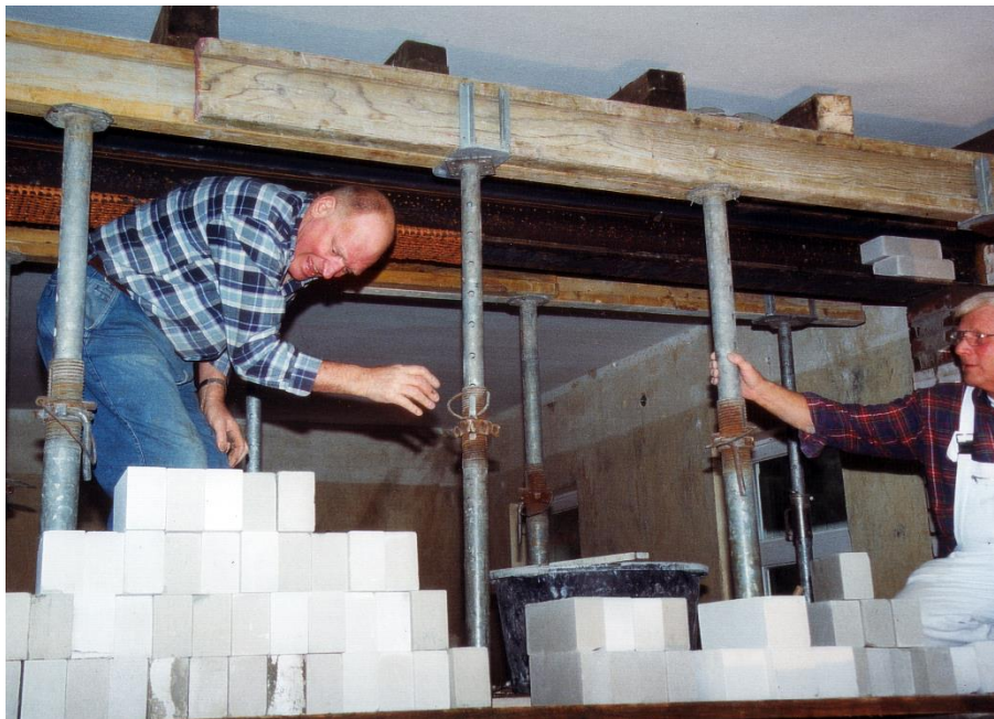
Um einen großen Veranstaltungsraum zu schaffen, müssen Wände entfernt und Stahlträger eingezogen werden (Quelle: HVL)
